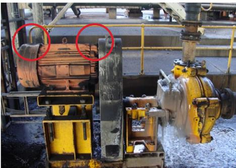
风扇和鼓风机通常在**异常**情况下运行。如灰尘或泵抽介质等**污染物**因通风设备操作而扩散。这些可进入轴承系统，会导致单个组件磨损加剧，缩短风扇的使用寿命。
